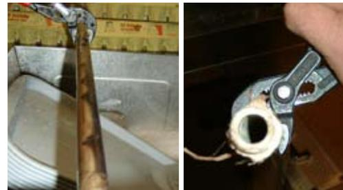
Der Düsenstock ohne Kalkablagerungen: Die Düsenöffnungen sind absolut frei.
