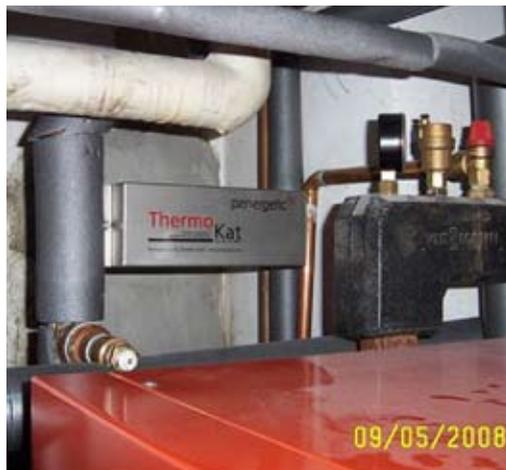
Montage eines ThermoKat am Heizungsverlauf direkt hinter der Kesselanlage
