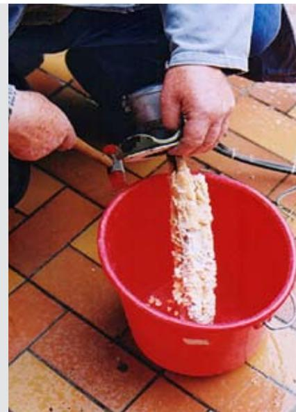
Die Kalkablagerung haftet lose und lässt sich leicht mechanisch entfernen.
