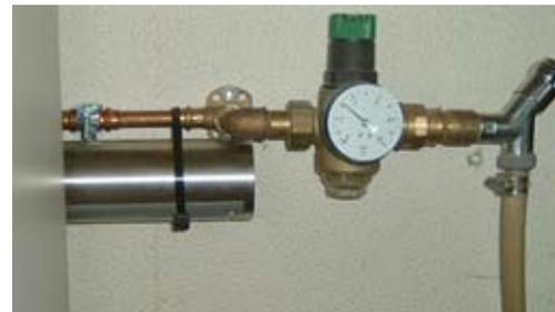
Montage des AquaKat L an der Wasserzufuhr vor dem Druckminderer des Backofens.
