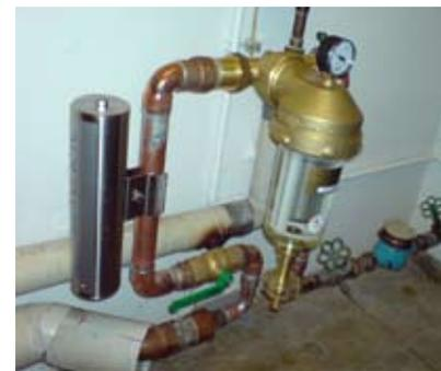
Montage eines AquaKat L an der Kaltwasserleitung hinter der Rückspülfilteranlage
