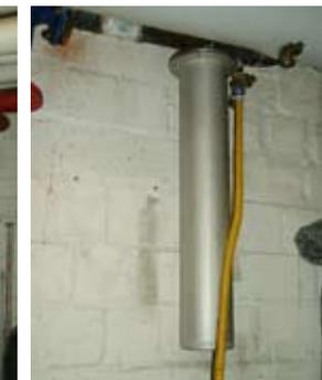
rechts: Anschluss des Entleerungsschlauches am Heizungs-Entleerungshahn
